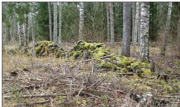
Osittain sortunutta kiviaitaa. Etelään.
