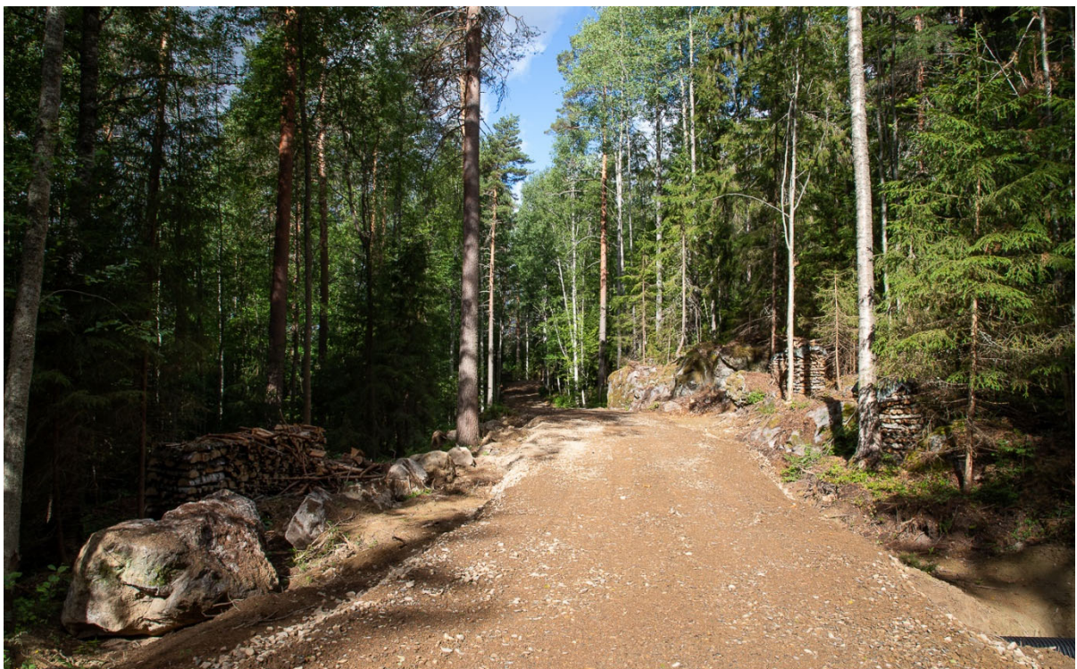
Kaavamuutosalueelle rakennettu tie. Kuva: Helena Väisänen
