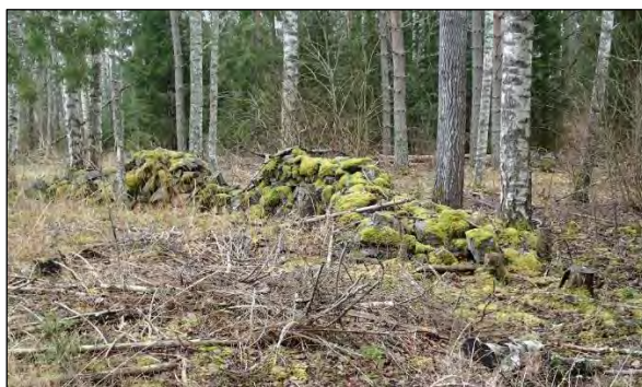
Osittain sortunutta kiviaitaa. Etelään.
