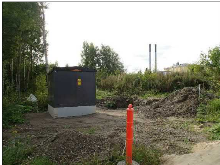
Kaapelikaivannon aluetta kaava-alueen luoteisosassa.
