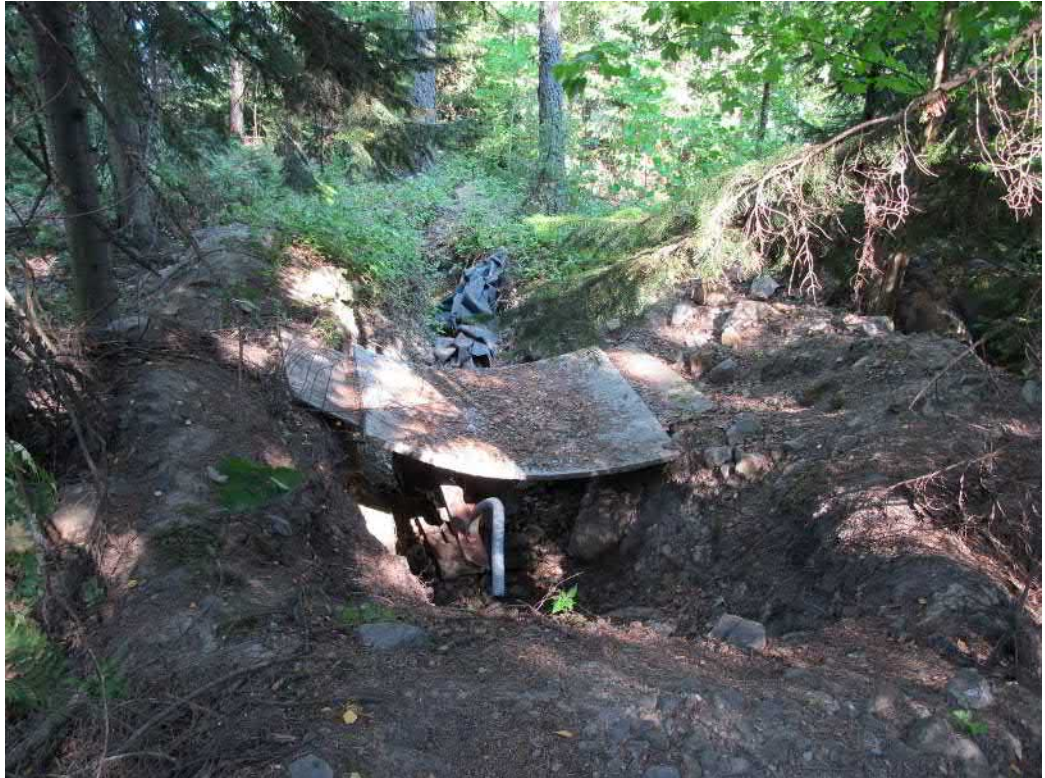
Kuva 7. Heinsaassa oleva kaivanto laitteineen.
