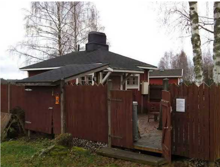
Saunan terassi on aidattu
