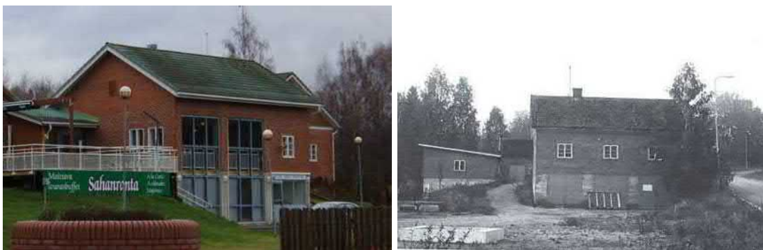
Entinen trukkihalli on muuttunut harjakatolliseksi. Kuva oikealla: Autotalli (oik.) ja trukkihalli. (Vanha valokuva Kirkonkylä Päijänteen kainalossa s. 151)
