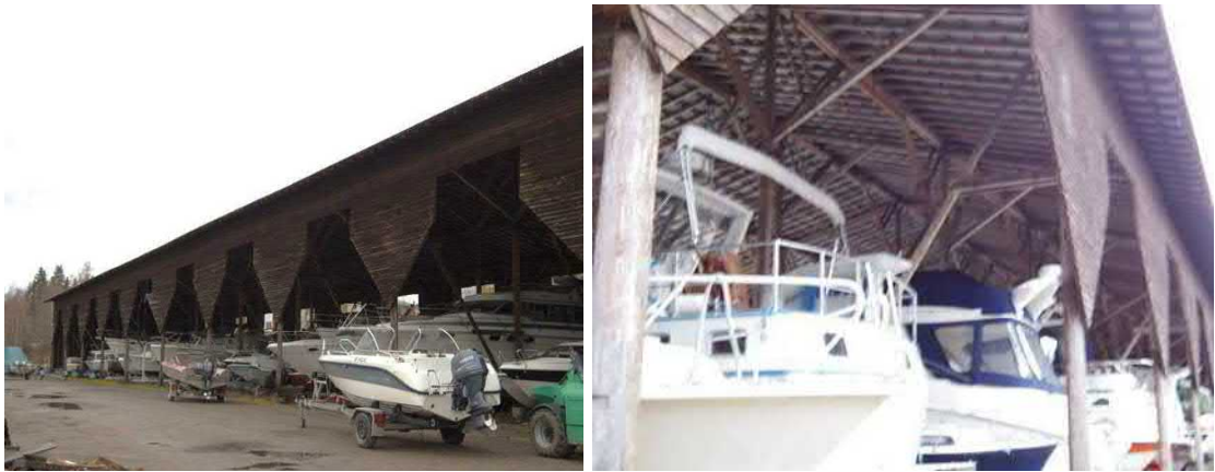
Kuuri eli katos. Kuva oikealla: Kuurin ristikkorakenteita
