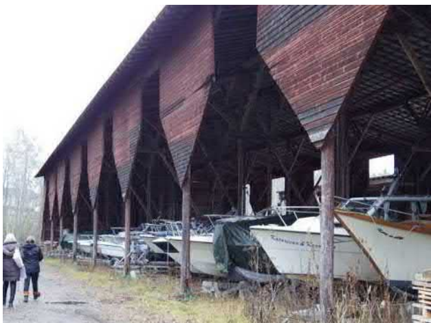
Luoteisjulkisivu on jäsennetty pylväiden laudoituksella
