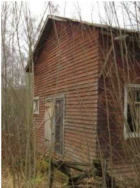
Rakennuksen päässä sijaitsi sahan taukotila.
